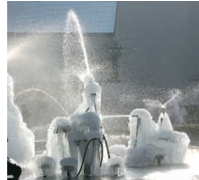
[50] Jean Tinguelys Fasnachtsbrunnen in Basel (1977) – ein Albtraum für die Konservierung: Korrosion durch Wasser, Umweltgifte und grosse klimatische Schwankungen, Abnutzung der beweglichen Teile, Alterung der Motoren.
