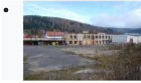
Steubing & Co, the former AR Breinl, ul. 5. května čp. 231
